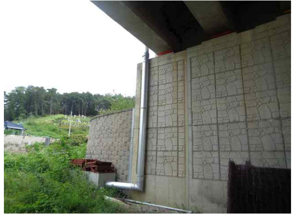
배수시설 배수관 상태양호
