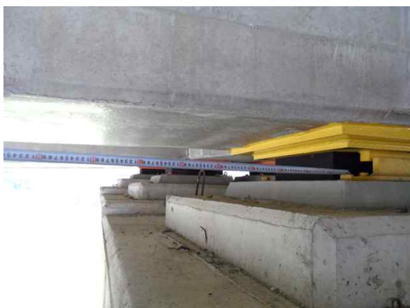
받침장치 연단거리 측정
