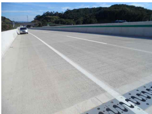
교면포장 S3 상태양호
