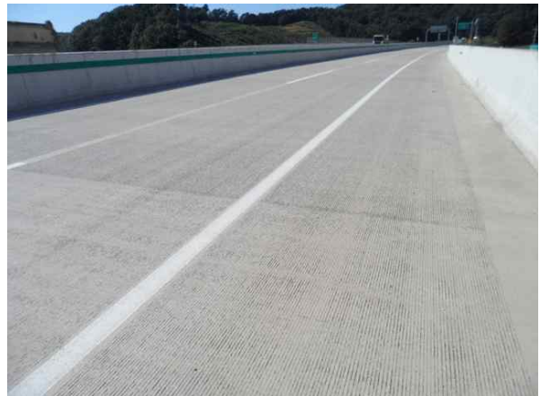
교면포장 S2 상태양호
