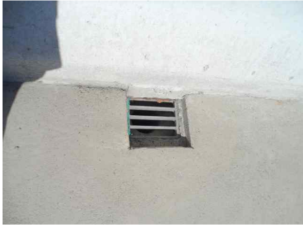
배수시설 배수구 상태양호
