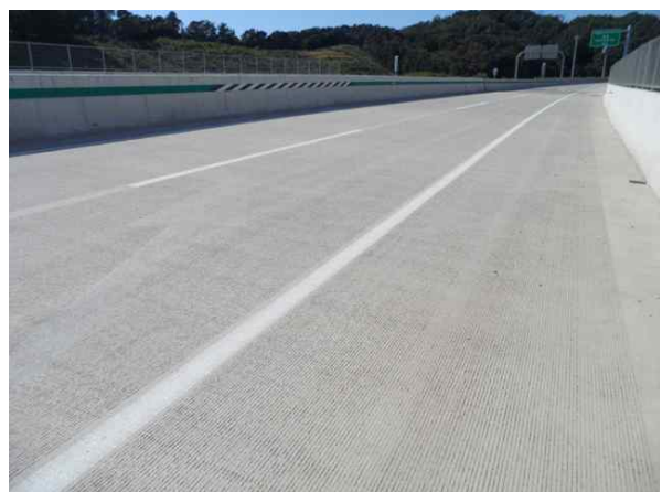
교면포장 S4 상태양호
