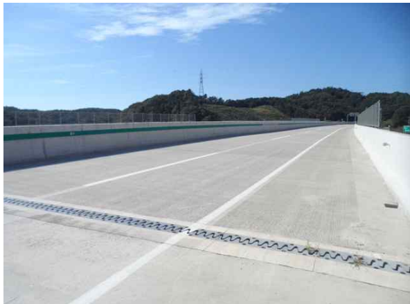
교면포장 S1 상태양호
