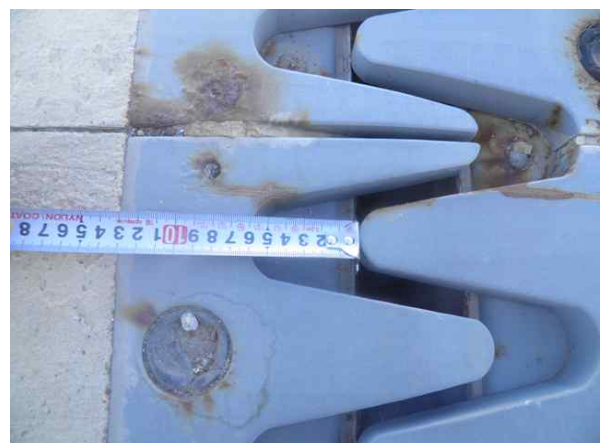
신축이음 이동량 측정
